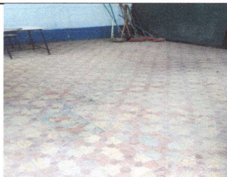
Foto 3: Sustitución de piso de granito del módulo 1
