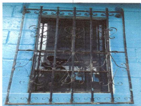
Foto 6: Sustitución de Balcones de metal.
