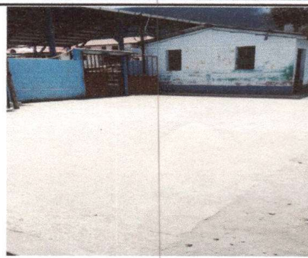
Foto 2: Sustitución de piso de torta de concreto del módulo 1
