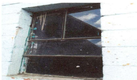
Foto 5: Sustitución de estructura de metal de ventana.
