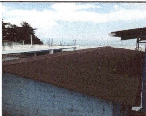
Foto1: Sustitución de lámina, por lámina troquelada aluzinc calibre 26 del módulo 1
